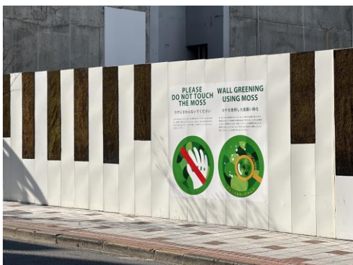
▲苔を使用した建設現場仮囲い全景
